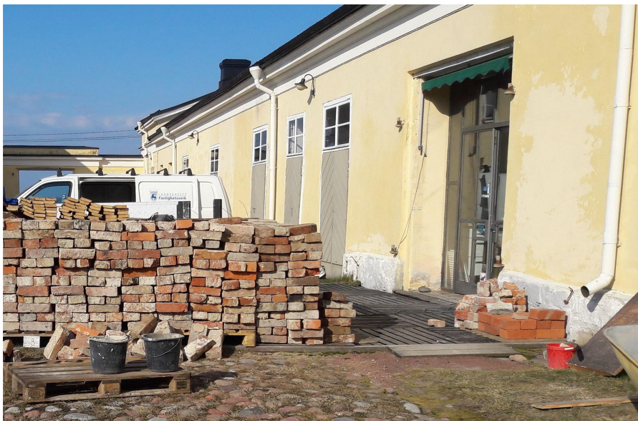
Bild: Vid grundrenoveringen av café vid Eckerö post och tullhus återställdes det ursprungliga golvet i det som varit stall och vagnsskjul.
