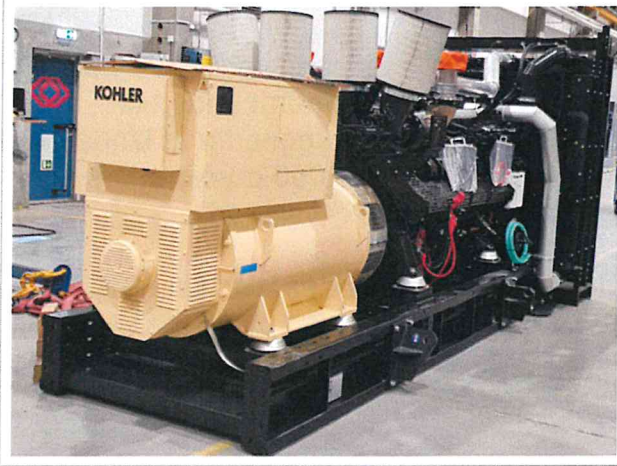
Bild: En av två nya dieselgeneratorerna. De har placerats i separata hus i den norra delen av tomten vid sjukhuset i Mariehamn.
