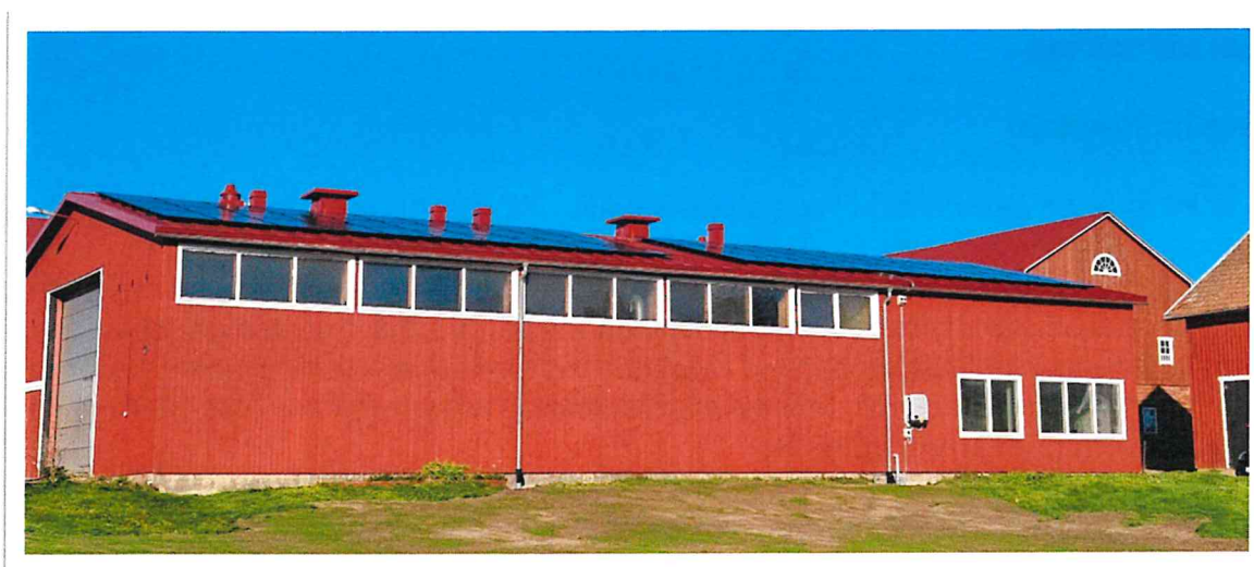
Bild: Nya solpaneler på maskinhallen vid Jomala gård. Taket målades innan panelerna installerades.
