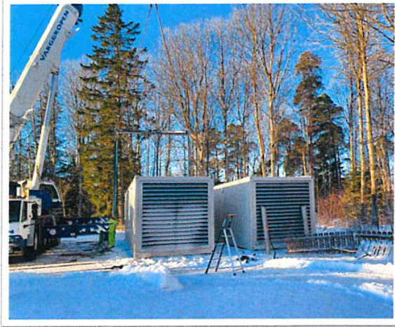
Bild: En av två nya dieselgeneratorerna. De har placerats i separata hus i den norra delen av tomten vid sjukhuset i Mariehamn.
