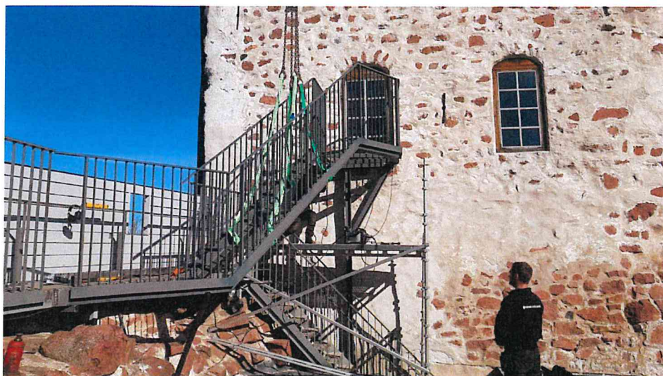
Bild: Trappan till kuretornet installeras.
