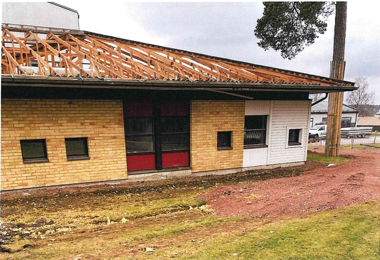
Bild: Rivning av två sedan länge oanvända längor vid Gullåsen.
