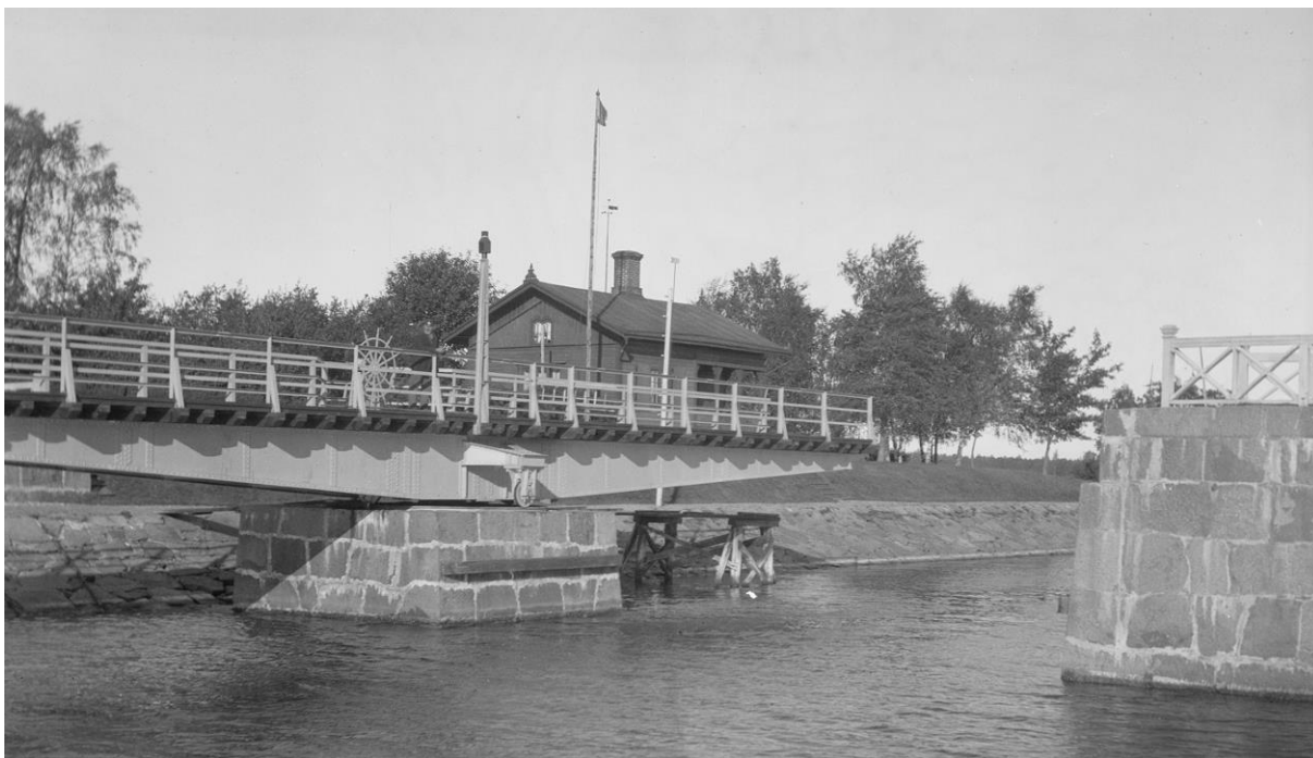
Figur 13: Kanalbron i öppnat läge under början av 1900-talet. På bron syns en signallykta som visar rött för stängd bro och vitt för öppen bro. Med flaggstången signalerades strömriktningen i kanalen. Foto: Riksarkivet.
