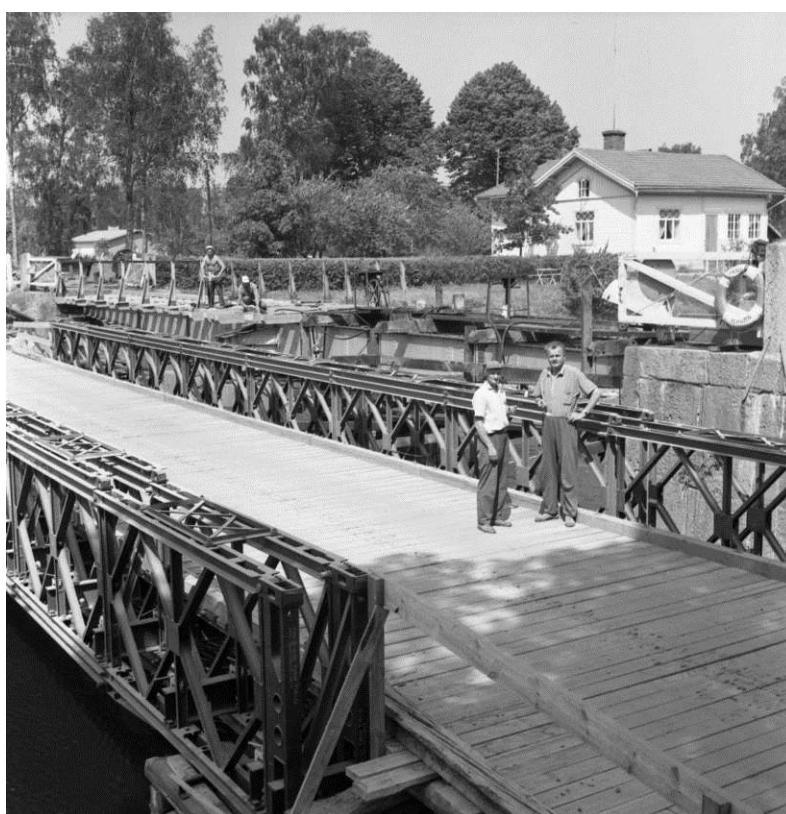
Figur 14: Brons överbyggnad av trä breddades och förstärktes år 1966. En tillfällig fackverksbro har byggts upp bredvid och arbete med att byta bronns träöverbyggnad pågår i bakgrunden. Foto: Ålands museum.
