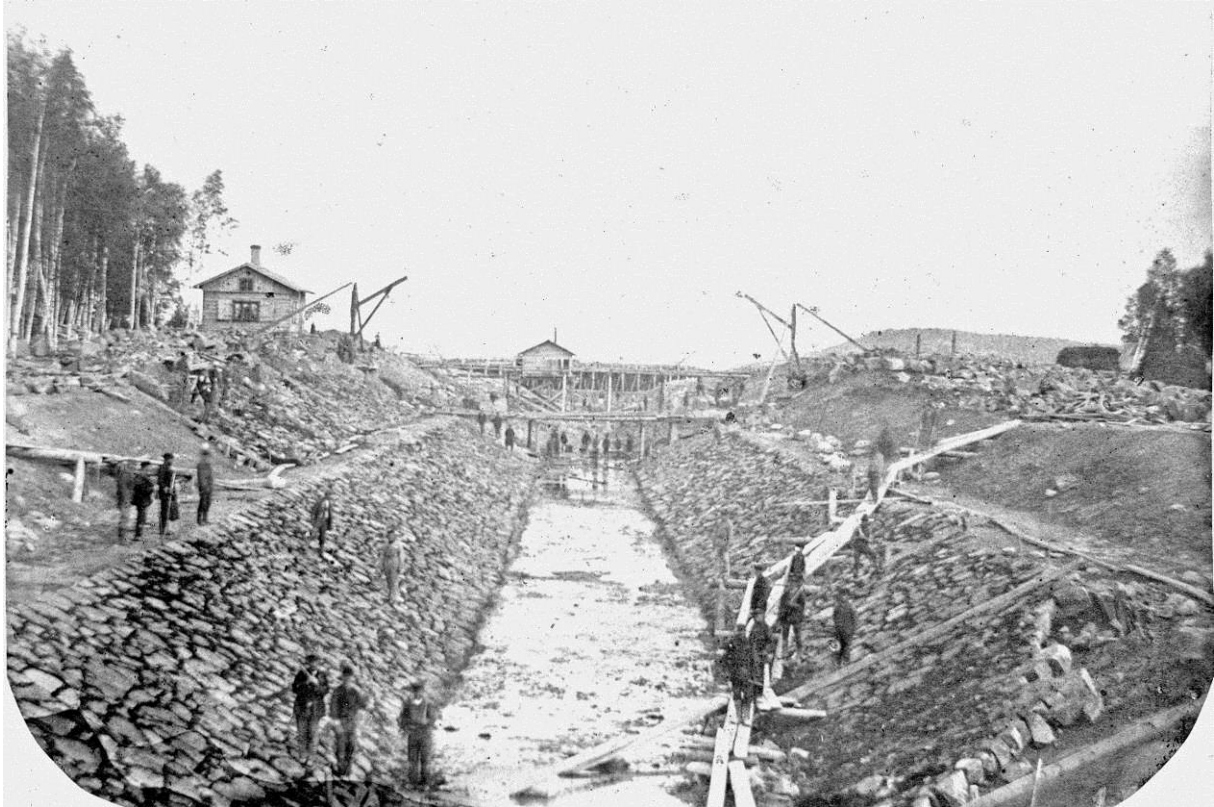
Figur 6: Lemströms kanal under byggnad på 1880-talet, från väster. Arbetarna har ställt upp sig längs den nygrävda uppdamda kanalen vars kanter man är i färd med att stensätta. Till vänster syns en nyss uppförd timmerbyggnad som därefter kom att inredas som kanalvaktarbostad.
