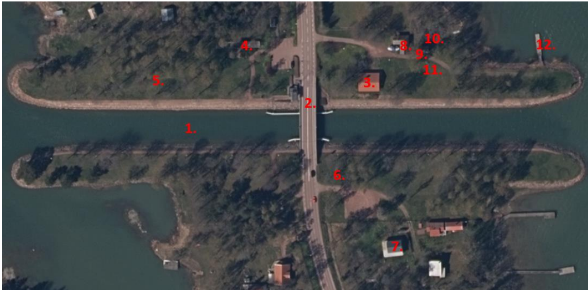
Figur 16: Översiktsbild: Lemströms kanal
